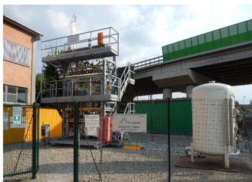
Impianto pilota su scala di laboratorio per la depurazione del gas acido - Piacenza
